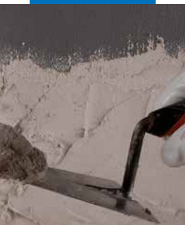
Applicering av puts över Eco Prim Grip Plus
